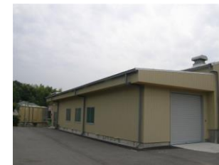
本社第二工場クリーンルーム
