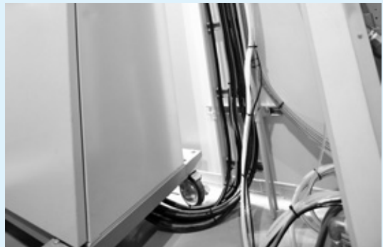
床の清掃効率を考慮して設備のケーブルは上方向へ配置
